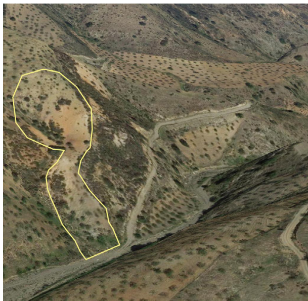
Figura 10. Signos de deslizamiento junto al cauce del arroyo Los Pilonos
