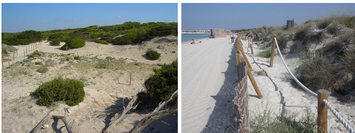
A: Cerramiento que fragmenta la duna interior semiestabilizada. B: Actuación sectorial de cerramiento ubicado detrás de la barrera de interferencia eólica.
