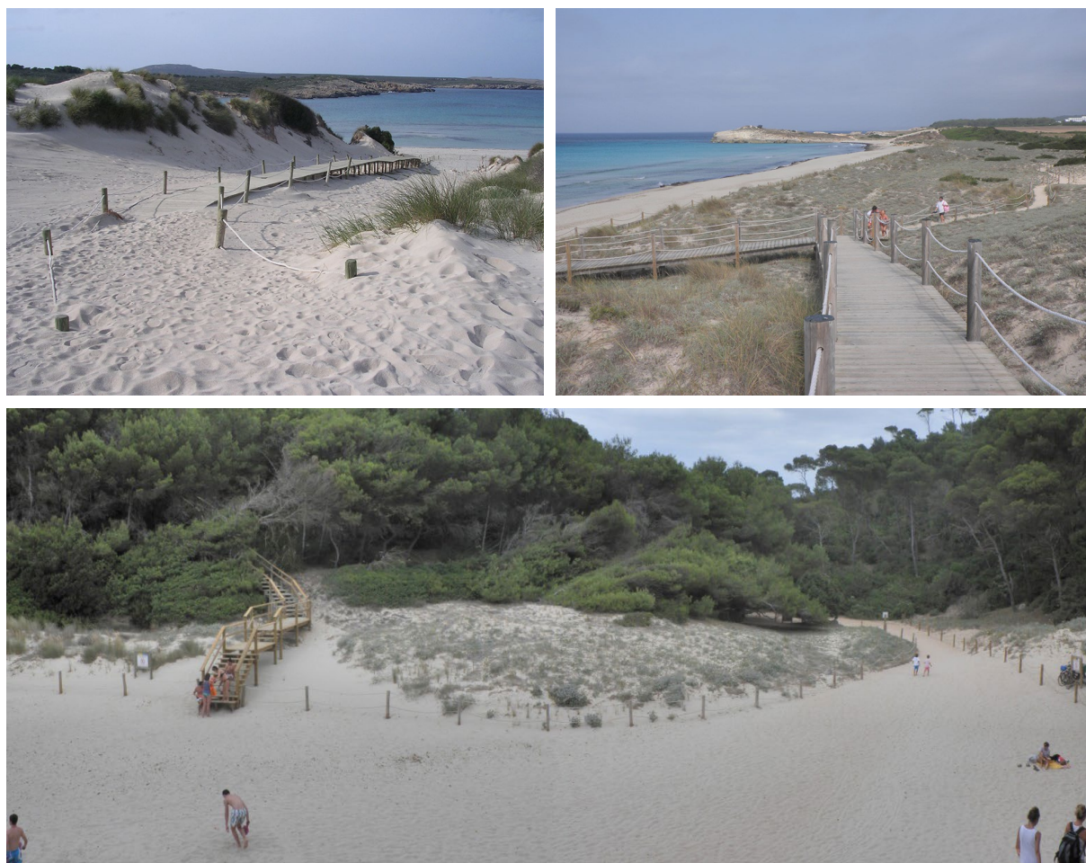
A: Instalación de una pasarela sin tener presente la dirección del viento dominante (Son Saura del Nord, Menorca). B: Pasarela construida sobre la foredune estable (Son Bou, Menorca). C: Pasarela que fragmenta el cordón dunar, generando procesos de deflación en sus bases. (Cala Mitjana, Menorca).
