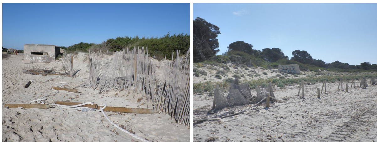
A: playa de es Trenc (Mallorca). B: playa de es Carbó (Mallorca), convirtiéndose estas instalaciones en elementos que favorecen procesos erosivos en el frente dunar.
