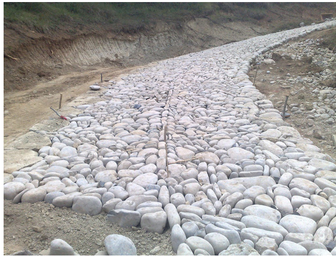
Figura 3. Restauración del Camino de Santiago en Aragón
