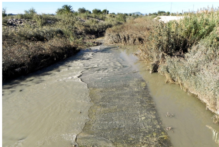
Figura 16. Azud de Alfeitamí.
