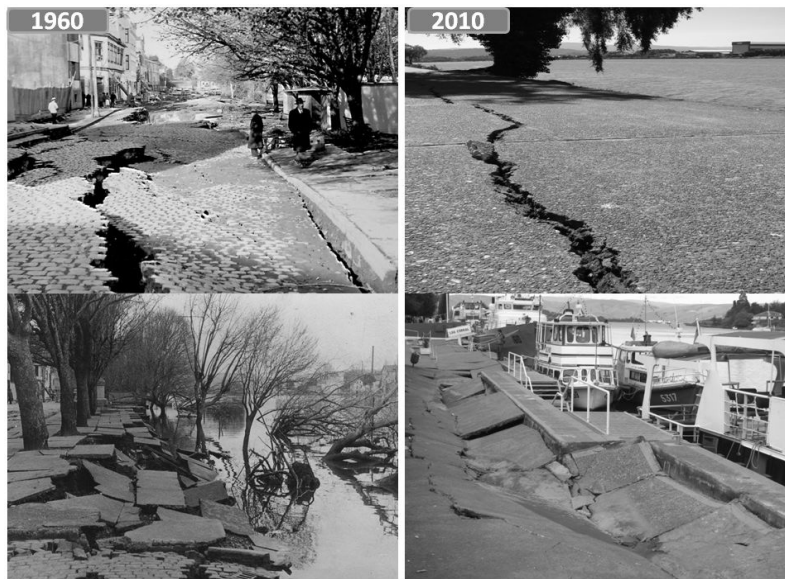
Figura 7. Imágenes comparativas de los daños en la Avenida Costanera (sismos de 1960 y 2010).
